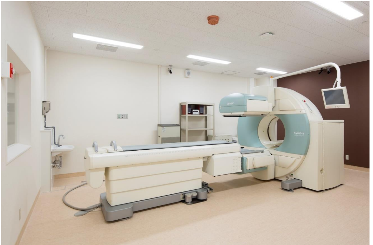
本館地下1階RI検査室
