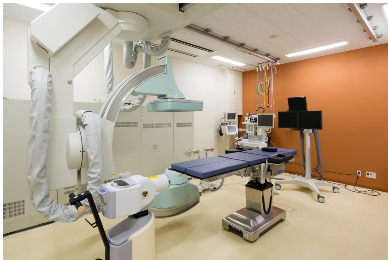
本館地下3階小線源治療室
