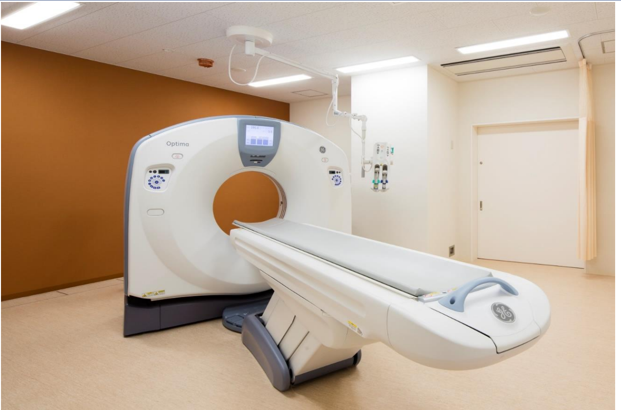
本館地下1階CT室
