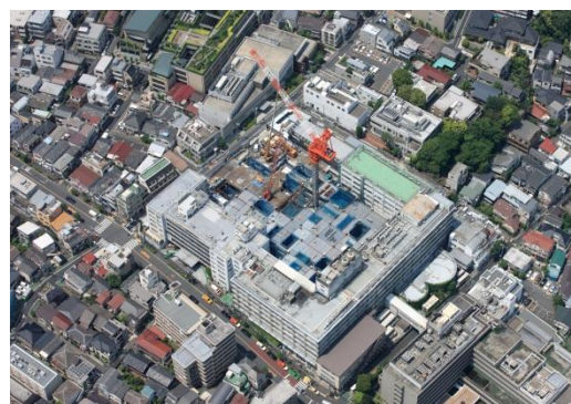
平成 25 年 5 月 14 日 (地下階工事中)
