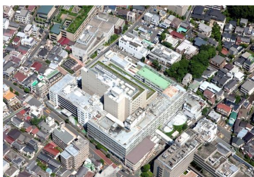
平成 26 年 6 月 13 日 (前期工事完了後)
