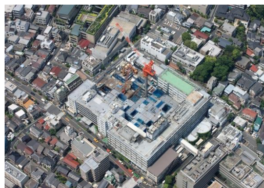
平成 25 年 5 月 14 日 (地下階工事中)
