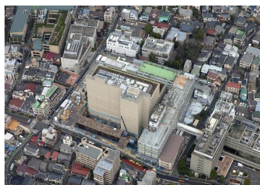
平成 28 年 3 月 12 日 (A・B 棟解体工事後)
