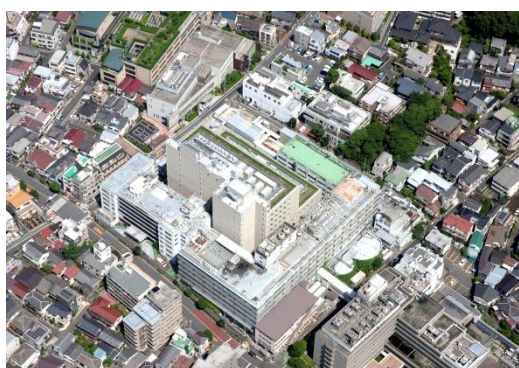
平成 26 年 6 月 13 日 (前期工事完了後)
