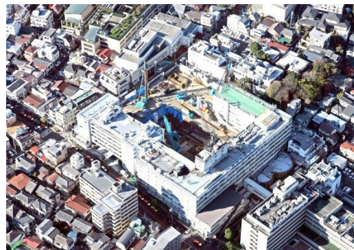
平成 23 年 12 月 15 日 (既存建物解体完了・地下工事中)
