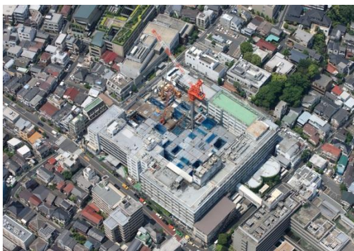
平成 25 年 5 月 14 日 (地上階工事中)
