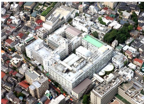
平成 22 年 9 月 13 日 (工事着工前)
