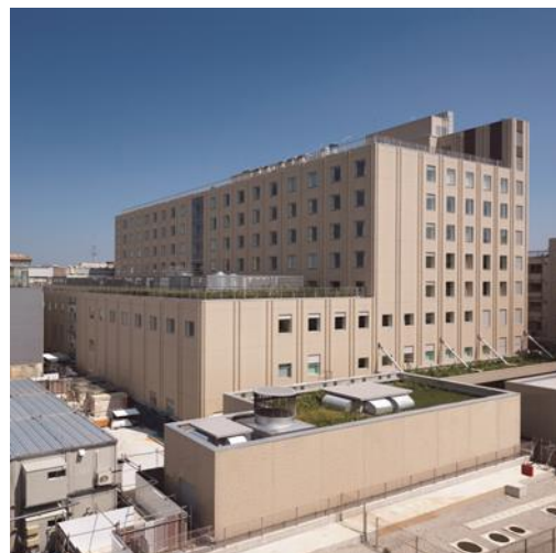
前期工事完成写真
