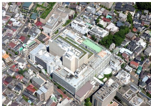
平成 26 年 6 月 13 日 (前期工事完了後)
