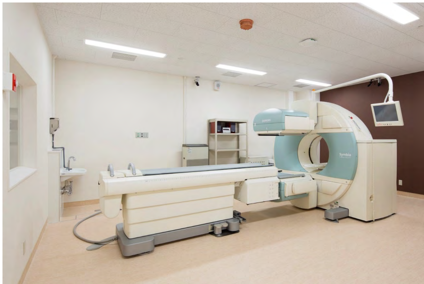
本館地下1階RI検査室
