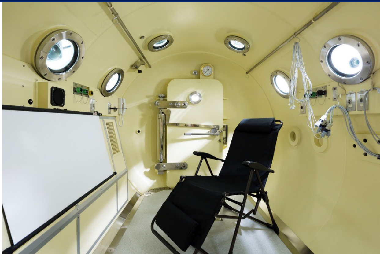
本館地下2階高気圧酸素治療室
